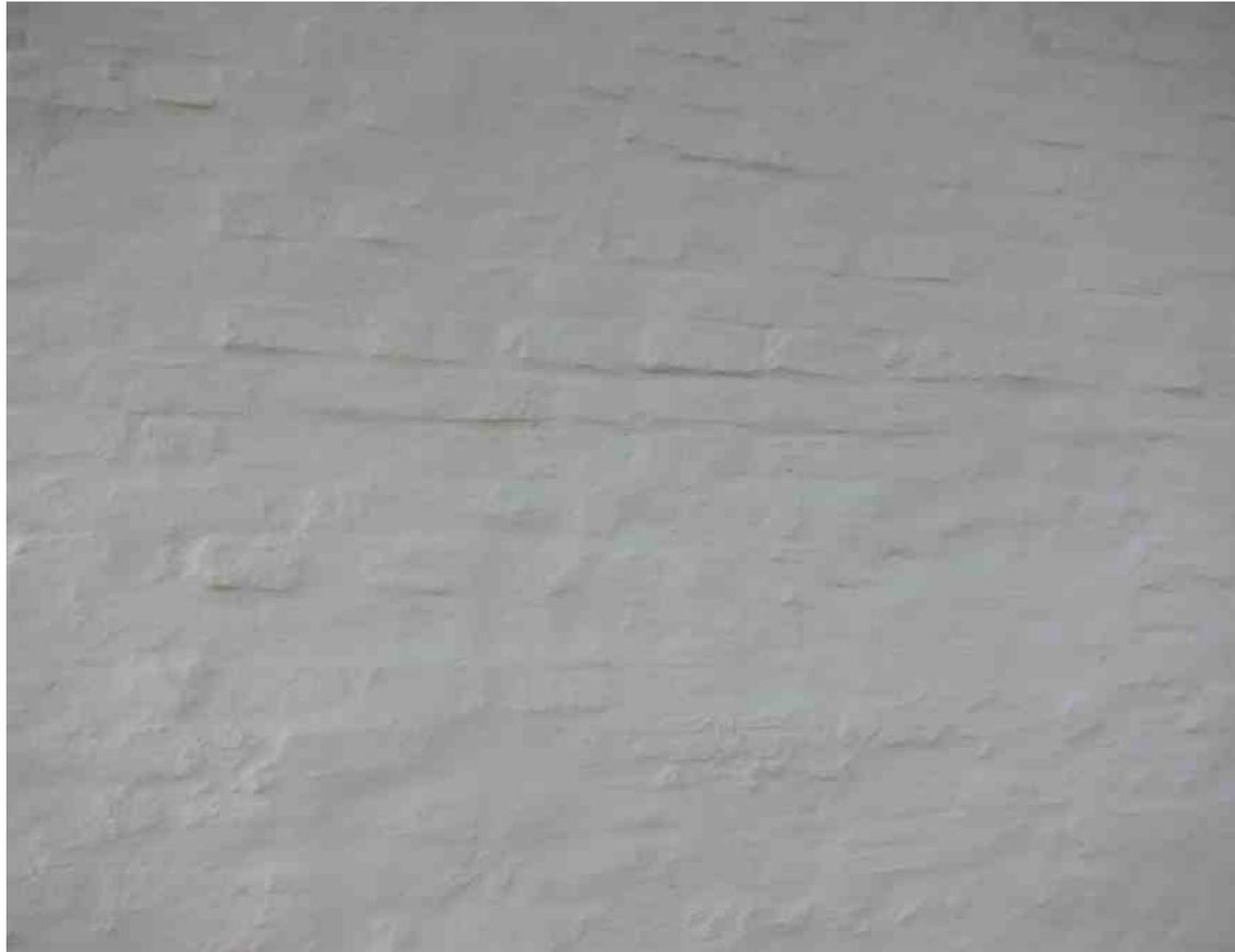
**Putz** Bei den alten zum Teil 60 cm starken Wänden wurde der alte Putz vollständig abgeschlagen und durch einen feinen Schlemmputz aus Kalkzement ersetzt. So werden z.B. alte zugemauerte Türbögen als Relief in der Wand sichtbar. Die Struktur der darunter liegenden Backsteinmauern geben zudem eine schöne Wechselwirkung von Licht und Schatten in der Mauer Oberfläche. Im Kontrast dazu wurden alle neu hinzugefügten Elemente sichtbar glatt verputzt.
